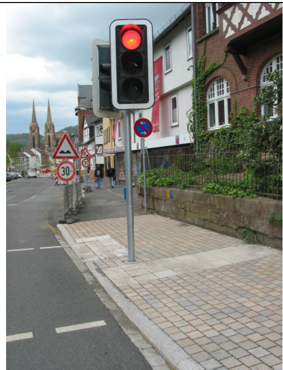
Abb. 3 b: Die erste im öffentlichen Straßenraum gestaltete, für blinde Menschen sorgfältig abgesicherte Getrennte Querungsstelle in Marburg
