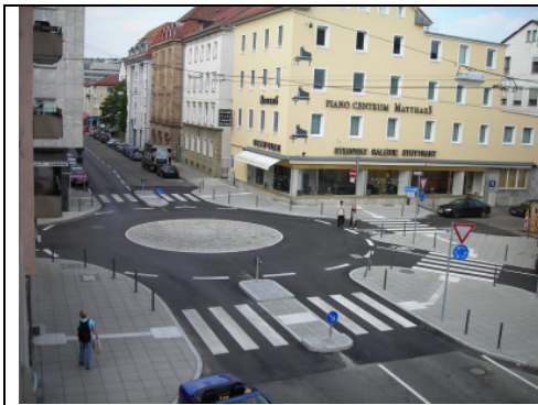
Abb. 12a: Kreisverkehr mit 3-cm-Bordhöhen und Blindenleitsystem (Foto: Tiefbauamt Stuttgart)
