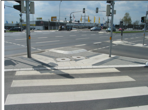
Abb. 14: Eine Nullabsenkung über die ganze Breite der Querungsstelle wird von den im GFUV vertretenen Verbänden (s. Anm. 1) keinesfalls akzeptiert!
