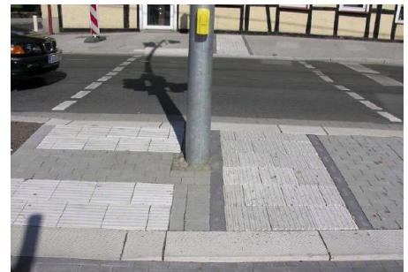
Abb. 9a: Die unterschiedlichen Bordhöhen am Straßenrand vor der Getrennten Querungsstelle einer Fußgängerfurt (Entwurf: Böhringer; Zeichnung: Mühr)
