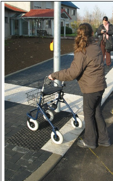
Abb. 3 a: Die erste, testweise gestaltete Getrennte Querungsstelle mit „Sperrfeld“ auf dem „Musterpark“ in Borken.
