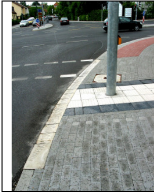
Abb. 2: Eine „Kombiquerungsstelle“, wie sie in jüngster Zeit in Deutschland gelegentlich gebaut wurde. Dabei werden blinde Menschen bewusst in die Nullabsenkung hineingeführt. Sie können so die Grenze zwischen sicherem Gehweg und gefährlicher Fahrbahn nicht eindeutig erkennen. Es besteht die Gefahr, dass ein blinder Mensch die Fahrbahn betritt in der Überzeugung, noch auf dem Gehweg zu sein. Diese Lösung wird daher von den im „Gemeinsamen Fachausschuss Umwelt und Verkehr (GFUV)“ 1 vertretenen Verbänden des Blinden- und Sehbehindertenwesens Deutschlands abgelehnt.
