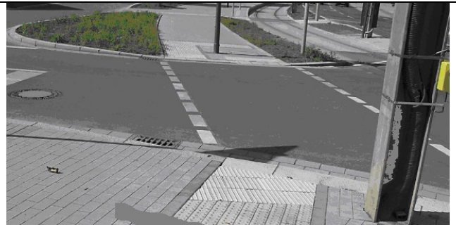
Abb. 11 b: Das Richtungsfeld weist exakt auf die gegenüberliegende Querungsstelle. Der genoppte Auffangstreifen verläuft in aller Regel in der Richtung der Rippen (siehe Abb. 10a). Dies ist aber nicht zwingend notwendig bzw. nicht immer möglich und sinnvoll. (siehe Abb. 10b). (Querungsstellen in Dortmund. Fotos: Kurt Nieft)
