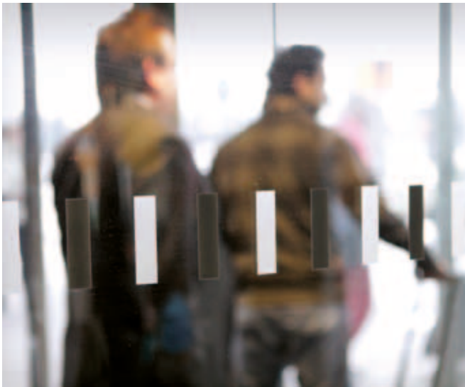
Sicherheitsmarkierung für Glastüren mit Hell- und Dunkelanteilen
