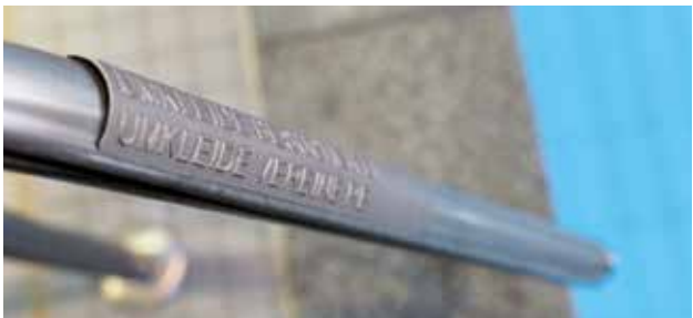
Taktile Beschriftung an einem Ausstieg aus einem Schwimmbecken
